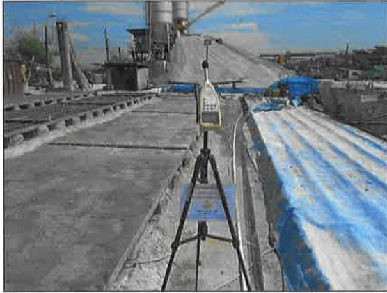
โรงงานผลิต Plank คลังสินค้า บริเวณท้าย Line ผลิต Zone 1
