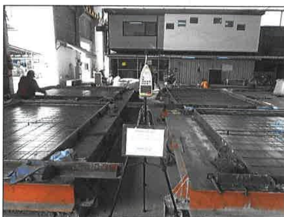
โรงงานผลิต HC : บริเวณหัว Line
