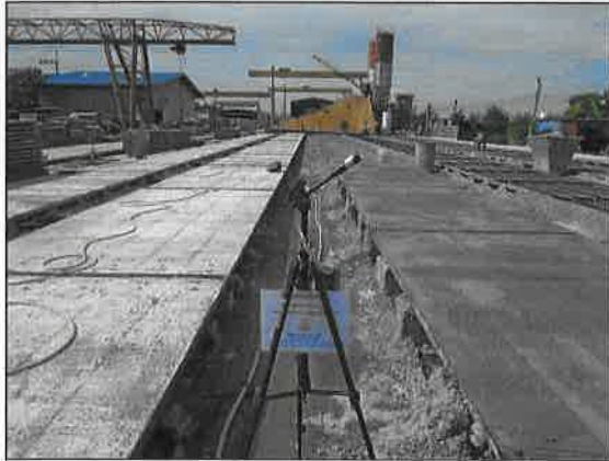
โรงงานผลิต Plank คลังสินค้า บริเวณกลาง Line ผลิต Zone 6 ตรวจวัด Total Dust
