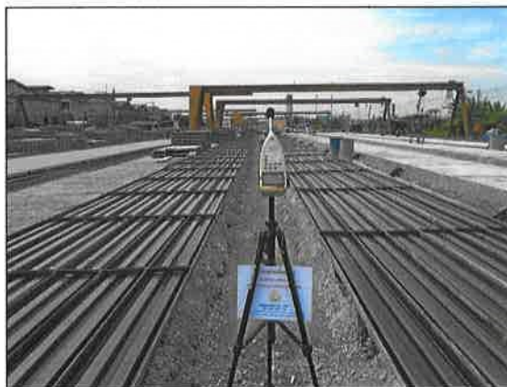
โรงงานผลิต Plank คลังสินค้า บริเวณกลาง Line ผลิต Zone 3
