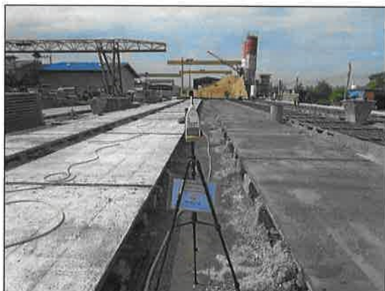
โรงงานผลิต Plank คลังสินค้า บริเวณกลาง Line ผลิต Zone 6
