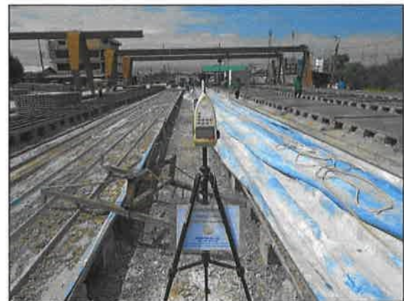
โรงงานผลิต Plank คลังสินค้า บริเวณกลาง Line ผลิต Zone 1
